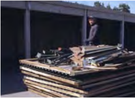
Befintlig port inkl karm demonteras. Med Dieden behåller du tidigare infartsbredd.
