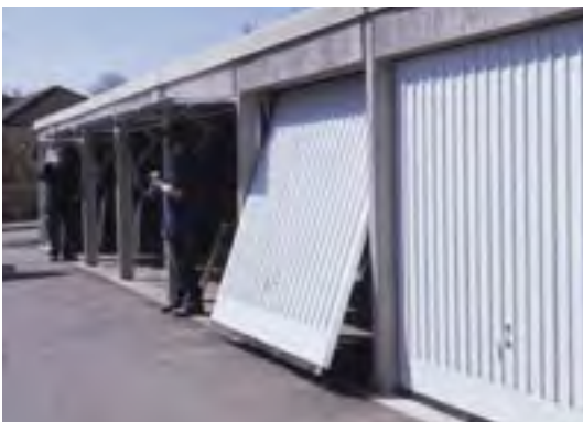
Porten är färdigjusterad på fabrik och kan tas i bruk direkt efter monteringen.
