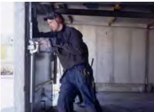
Två man ställer porten i sitt läge och skruvar fast karmen, utan skrymmande skenor i taket.
